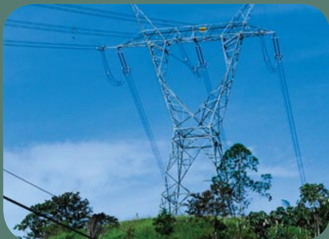
● Imagen representativa del Clúster Energía Eléctrica
