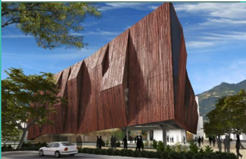
● Vista lateral del edificio de Ruta N
