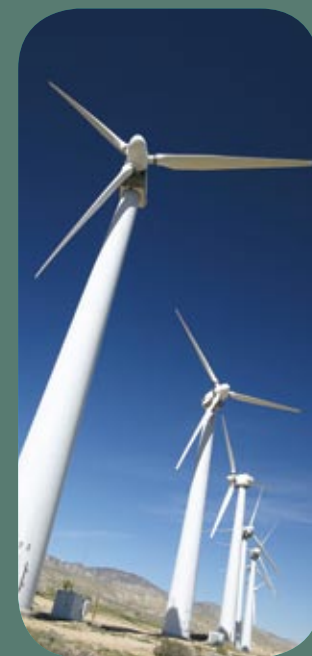
● Detalle aerogeneradores. Parque eólico Jepirachi. Guajira, Colombia
