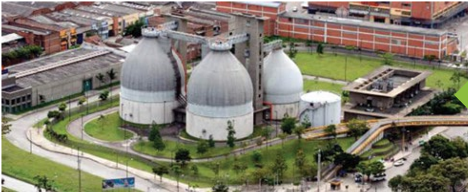
Planta de tratamiento de aguas residuales San Fernando. Fuente: el Colombiano
